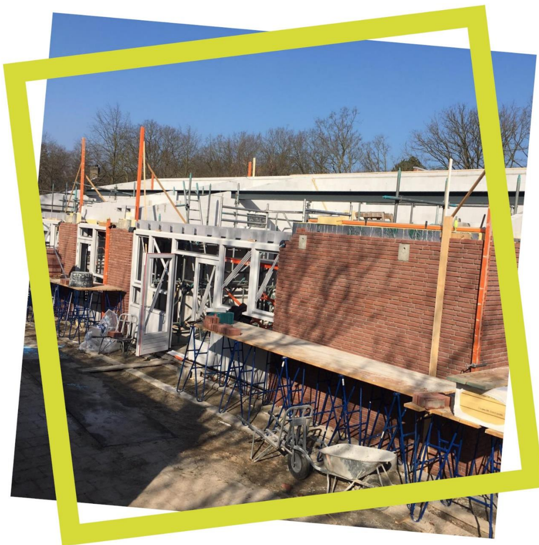
Foto: voortgang aanbouw (voor kinderopvang) basisschool De Harlekijn
